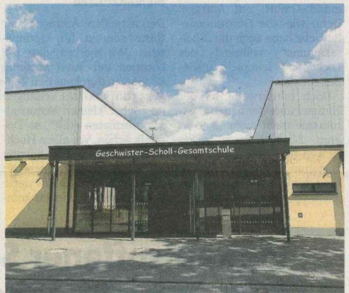
So schick sieht der Eingangsbereich des neuen Hallenkomplexes aus.
